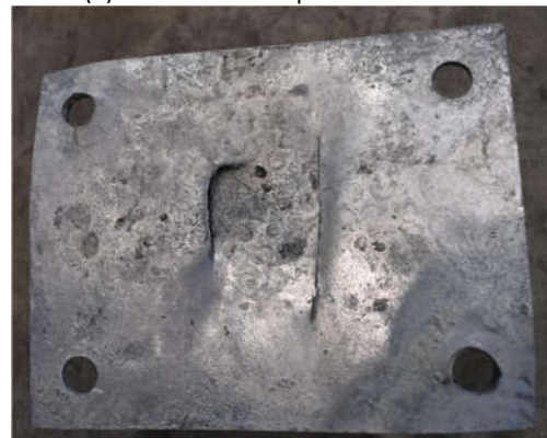
(d) Fracture through the floor plate
